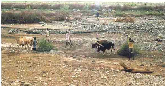
Réparation d'un barrage de déviation, Eritré
