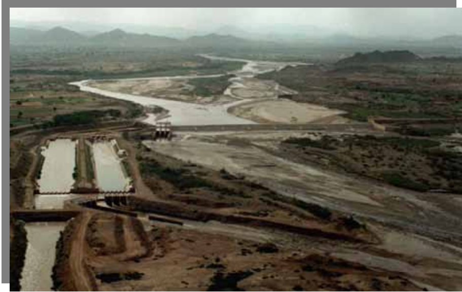
الشكل (13): تحديث فى منشآت كبرى على رى قيسى مع حوض ترسيب وحوض للكسورات, اليمن
